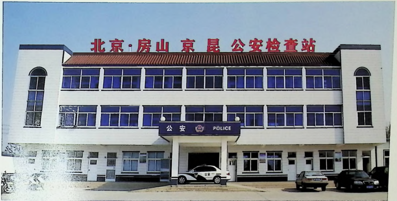
京昆高速进京检查站
