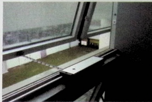
开窗机安装测试 Installation test
