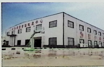
中国-山东智能制造生产基地 山东鲁泊瑞宝电气自动化有限公司 山东省济南市历城区机场路11999号
